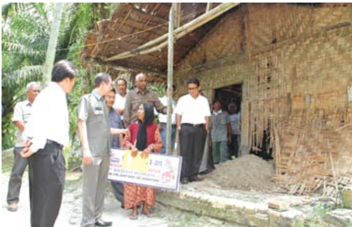
■ Kondisi rumah sebelum bedah rumah
