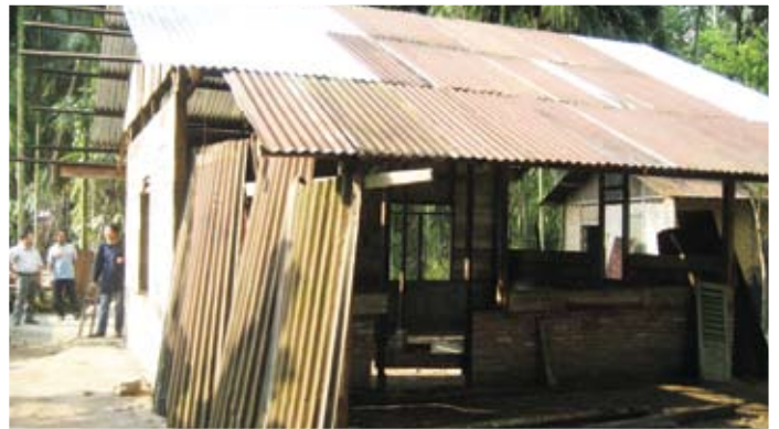
Kondisi sebelum renovasi.
