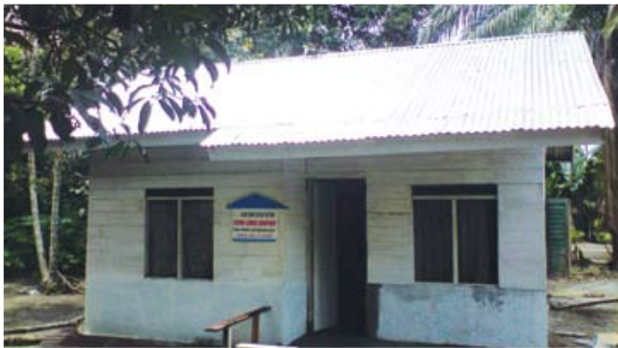
Kondisi paska renovasi.
