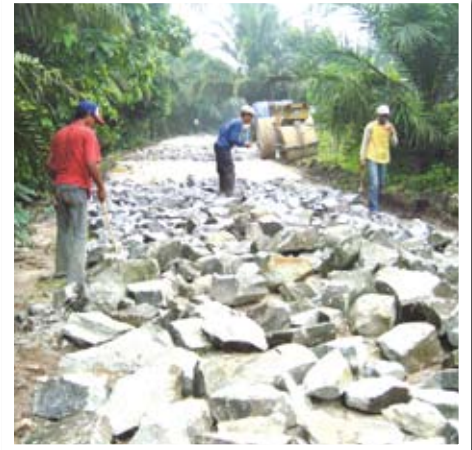
Perbaikan jalan desa sepanjang 500 meter.
